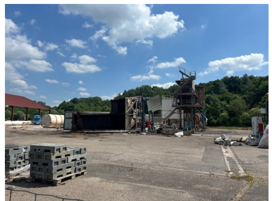
Arrêt de l'usine et démontage des installations
