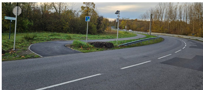
Sécurisation de la traversée...
