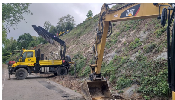
Engins de chantier utilisés lors de ces travaux
