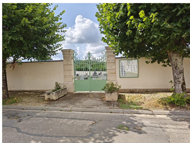
Fin des travaux pour le mur du cimetière
