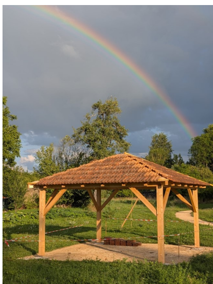
Le kiosque en cours de montage
