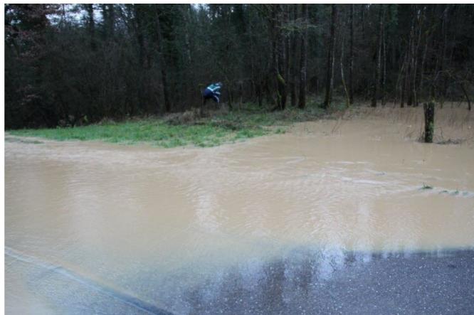
L'eau se retrouve à s'écouler sur la route
